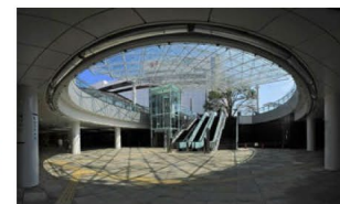
【静岡駅北口地下広場】
