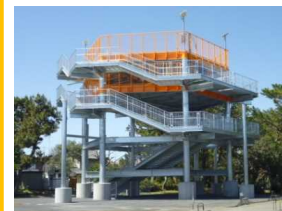
津波避難タワー
