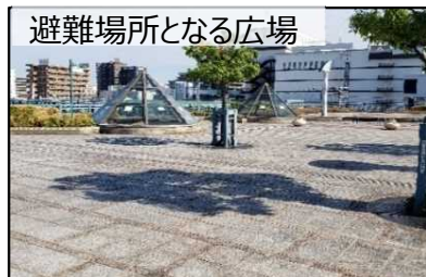
屋上の広場は浸水時に一時避難場所として活用
