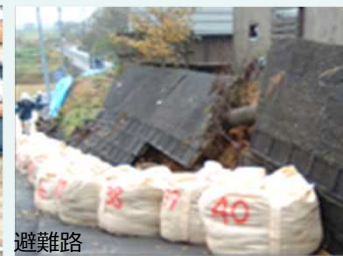
擁壁の防災対策
