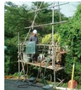
ボーリング調査
