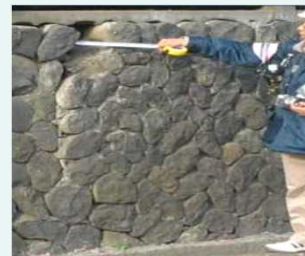
擁壁の危険度調査
