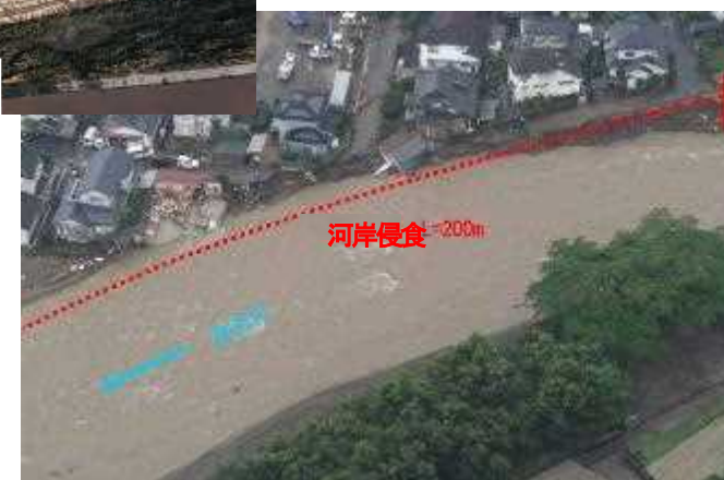
河岸侵食に伴う家屋倒壊等
