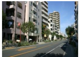
沿道建築物の不燃化
