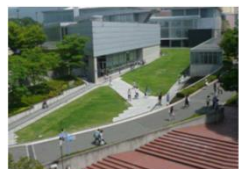
踏圧を受ける部分を舗装 提供：大阪芸術大学 (木田委員資料(第1回))
