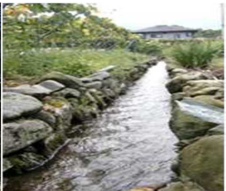
灌漑用水石積改修工事
