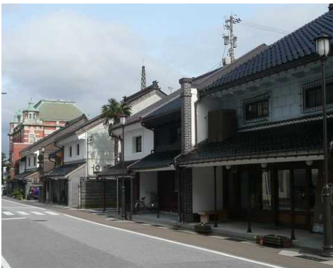
重要伝統的建造物群保存地区 保存修理・修景事業
