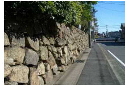
津山城宮川門跡石垣(津山市)
