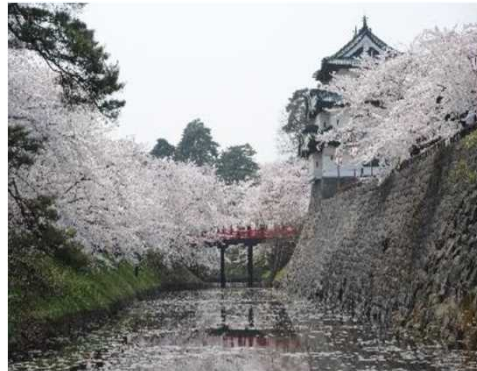
城の石垣修理・天守保存修理
