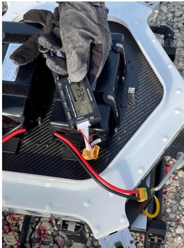
図表 35 バッテリー電圧測定時の様子
