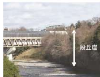
写真1-5 段丘崖に入る圏央道のトンネル
