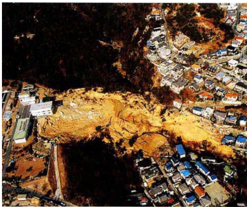
【すべり崩壊の例】主に、排水施設の機能不足により「盛土内の間隙水圧上昇による流動的すべり崩壊」が発生した事例。（西宮市仁川百合野町）
