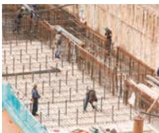
▲某病院基礎工事
